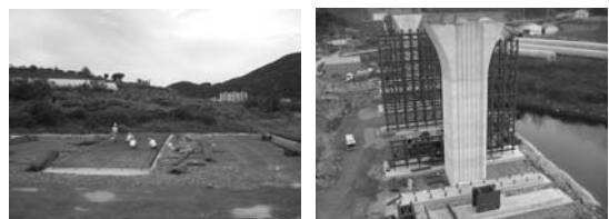
(a) Bent 기초 작업
