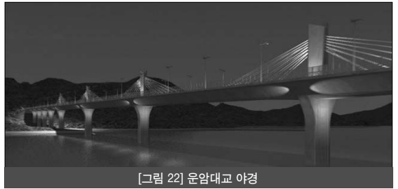
참고문헌 순창-운암(4공구) 도로확장공사 설계보고서, 2004, 쌍용건설㈜
