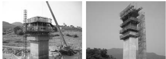
(e) 교각 시공
