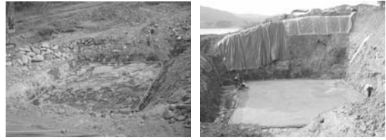
(a) 기초 터파기
